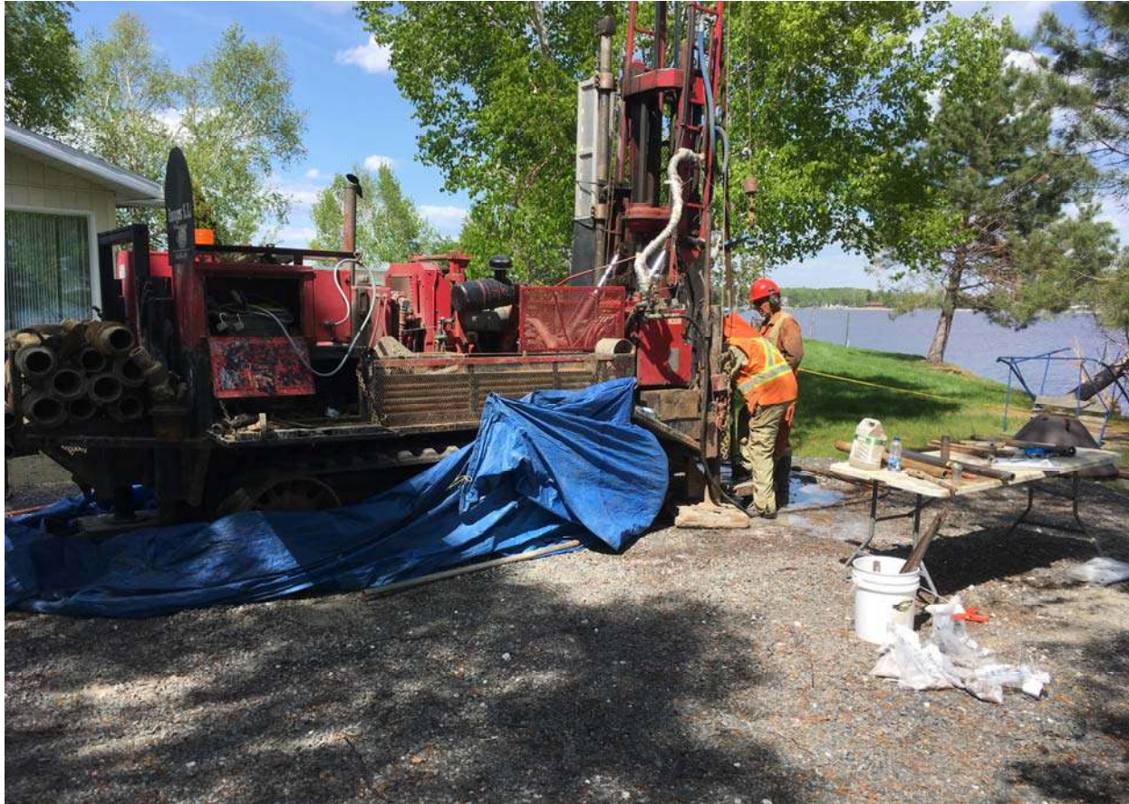
Figure 4 Foreuse Diedrich (modèle D-50) en opération au site du forage F-01-17
