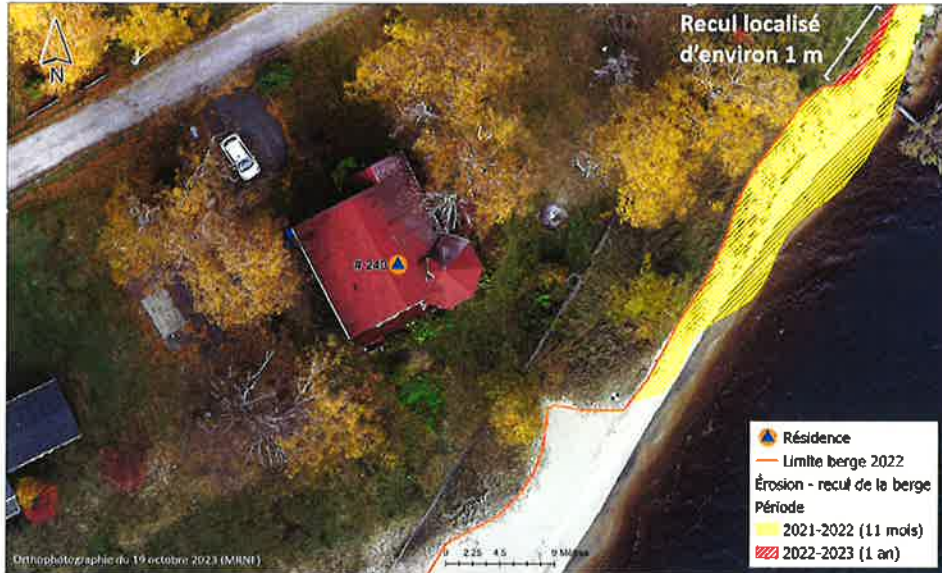
Figure 5. Évolution récente de l'érosion pour la propriété sise au 240, rue de la Pointe
