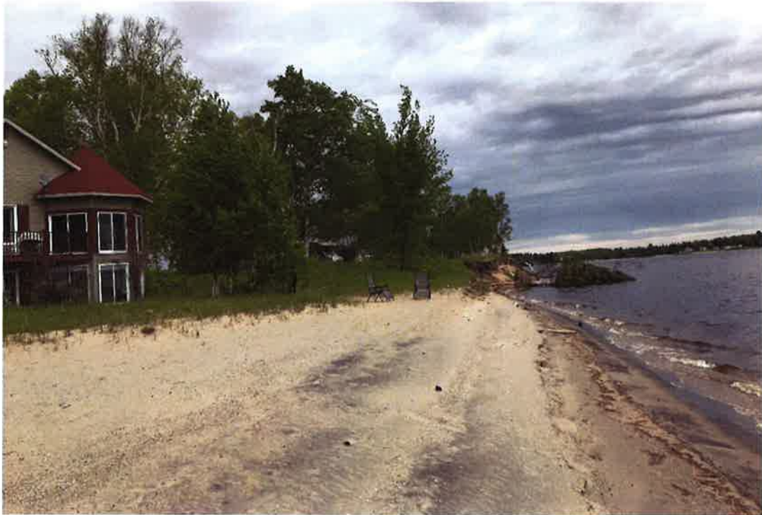
Figure 3. Vue générale de l'état de la berge au droit de la propriété sise au 240, rue de la Pointe (MSP, 7 juin 2022)
