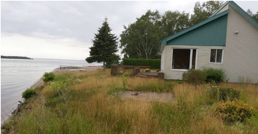
Figure 4: État des lieux en arrière de la résidence sise au 242, rue de la Pointe, en juillet 2019 (photo prise par la Municipalité).
