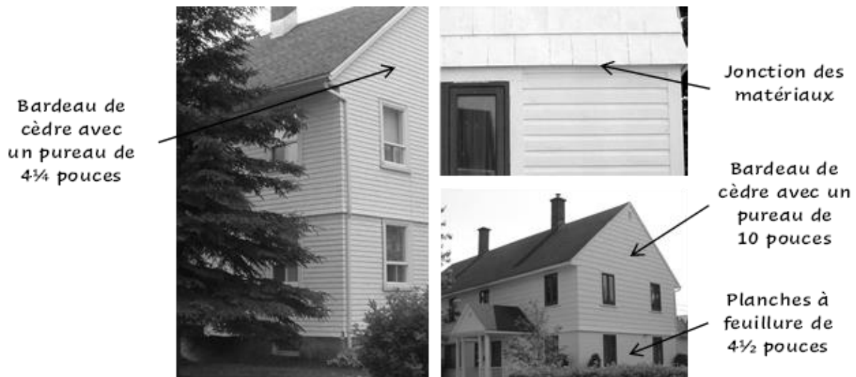
Photo A3 - Revêtement extérieur des murs
