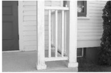
Garde-corps et poteaux
