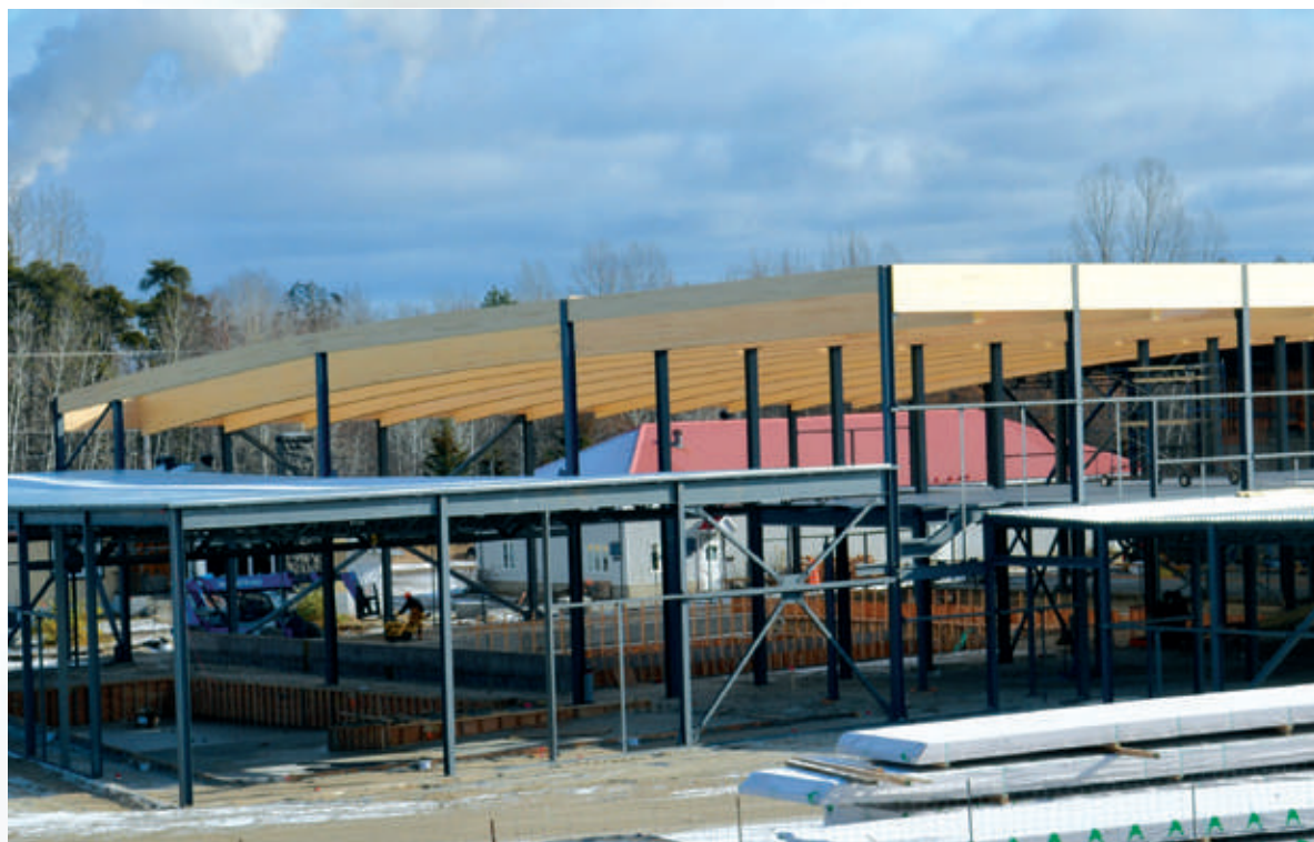
LES POUTRES DE BOIS DE LA STRUCTURE DU COMPLEXE AQUAGYM
