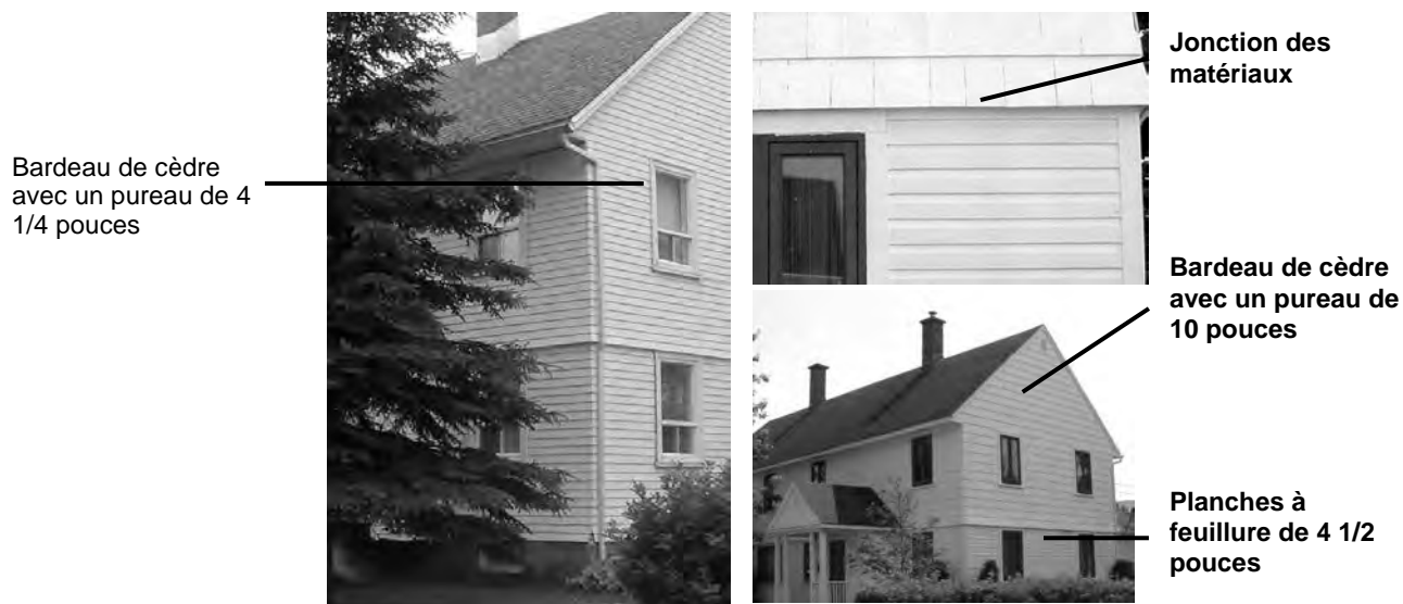
Photos 12, 13 et 14 : Revêtements des murs extérieurs Source : SARP, 2004
