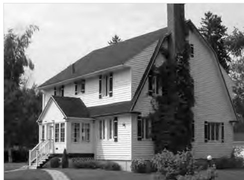
Photos 10 et 11 : Lucarne en chien assis et lucarne passante Source : SARP, 2004
