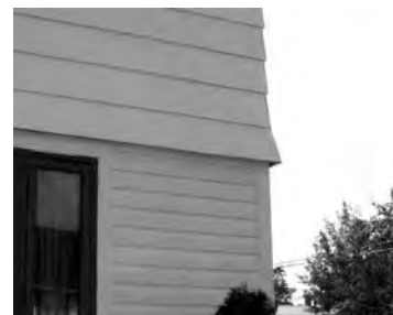
Renflement et planche cornière
