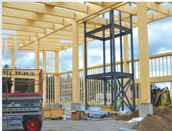
La construction de la nouvelle caserne va bon train et le Service de sécurité incendie devrait pouvoir y emménager au début 2017.
